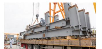
建て方順序にあわせて発送リストを作成し、大型トラック・トレーラーで輸送します。
